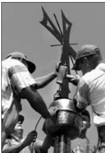
2002 Pokryvanie strechy kostola – osadenie kríža FOTO: V. BRIŠ
