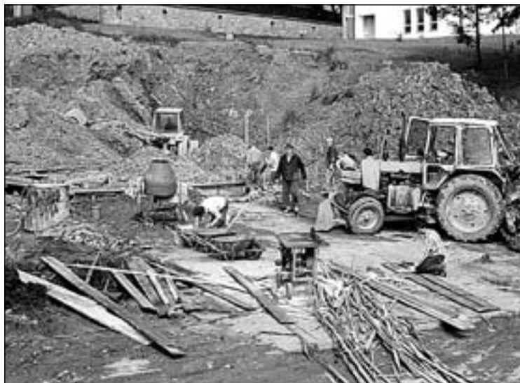
1995 Stavba fary v Sihelnom
