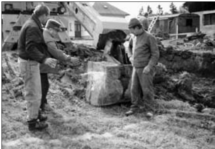
1997 – 1999 Výstavba novej farskej budovy – slávnostný prvý výkop pod vedením vedúceho RABČAN, obecné služby Jozefa Galisa FOTO: V. BRIŠ
