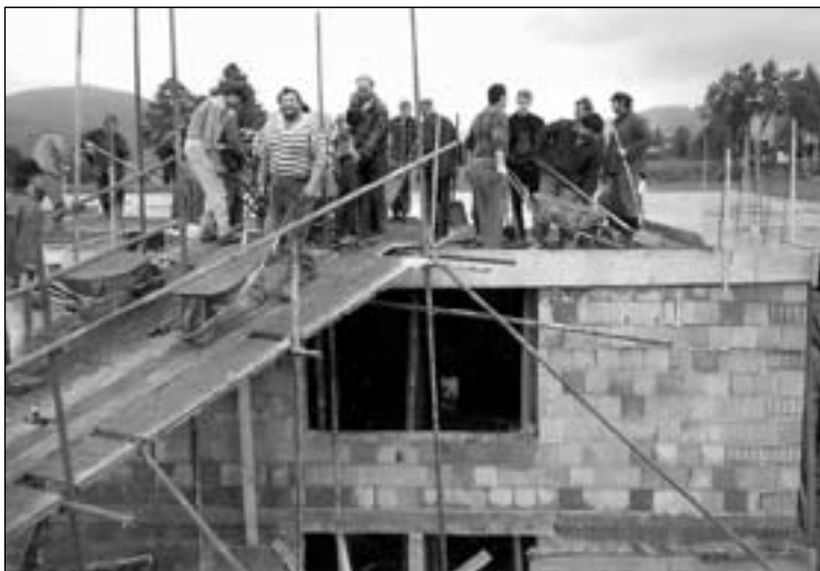
1997 - 1999 Výstavba novej farskej budovy - dobrovoľní brigádnicí dokončujú betónovú platňu („deku“) FOTO: JÁN ADAMČÍK
