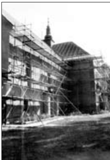
1992 - 1994 Oprava fasády, okrajov krytiny, odkvapových žlabov
