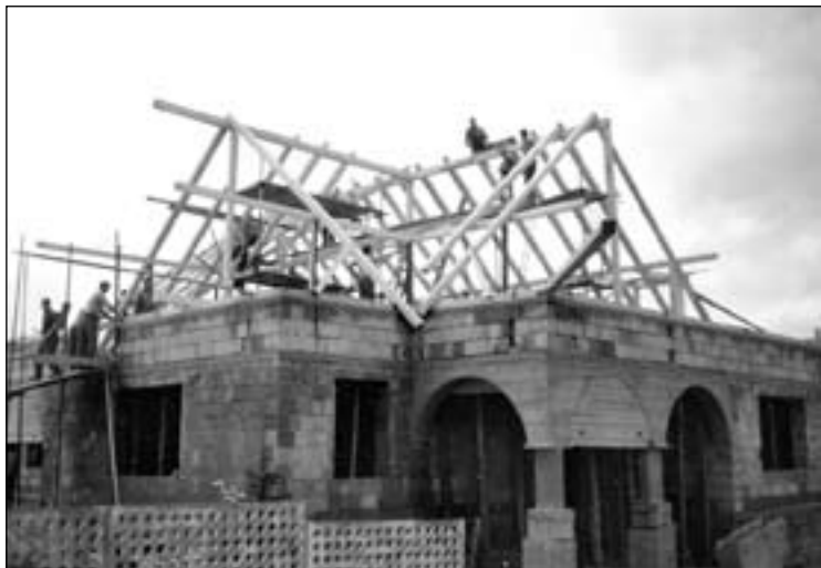
1997 - 1999 Výstavba novej farskej budovy - výstavba náročného dreveného krovu
