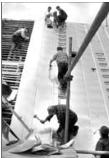
2002 Pokrývanie strechy kostola – klampiarske práce FOTO: V. BRIŠ
