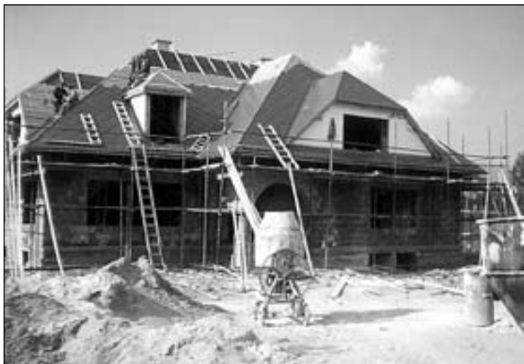
1997 - 1999 Výstavba novej farskej budovy - hrubá stavba sa blíži k záveru
