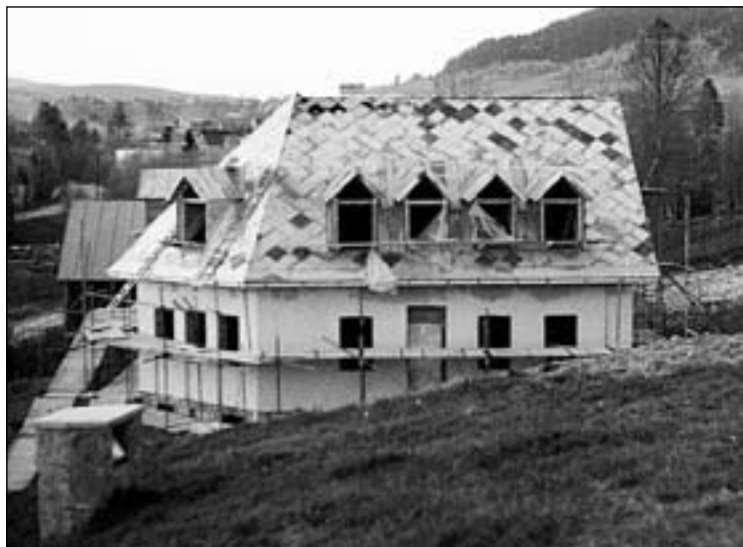
1996 Stavba fary v Sihelnom
