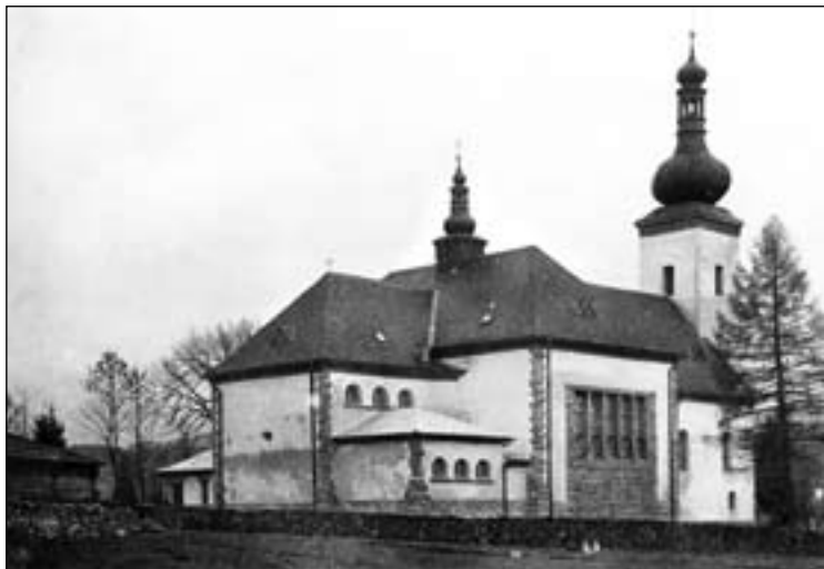
9. 11. 1930 Rabčiansky kostol po rekonštrukcii od západu
