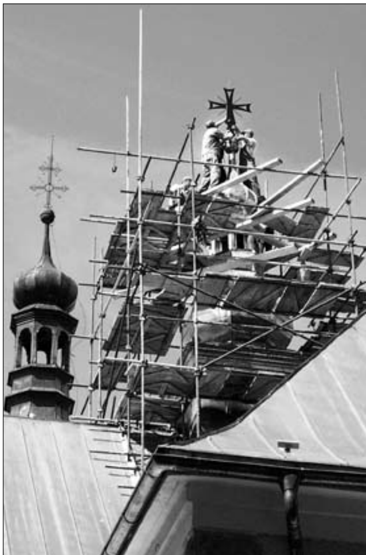
6. 5. 2002 – 15. 7. 2002 Pokryvanie strechy kostola Navštívenia Panny Márie medeným plechom. Záver prác klampiarov Hrubjákovcov
