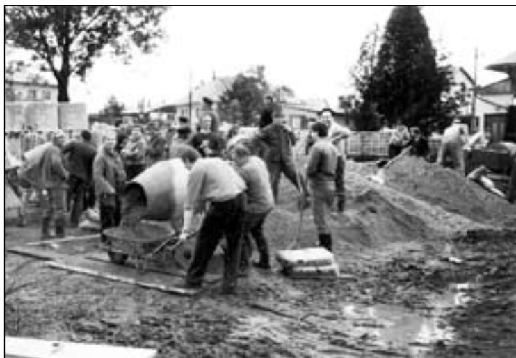
1977 – 1999 Výstavba novej farskej budovy – brigádnická práca veriacich z Rabče počas betonárskych prác
