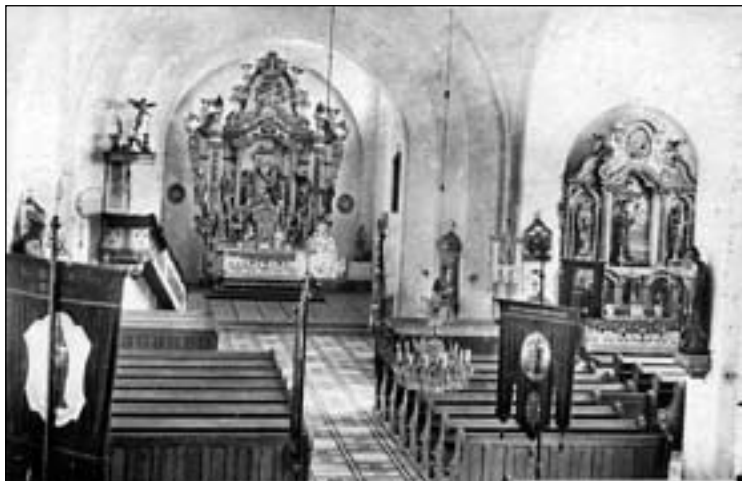
6. 11. 1930 Interiér chrámu Navštívenia Panny Márie. Kolaudácia rozšíreného kostola
